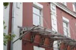
Крепление оттяжек и кронштейнов светопрозрачного козырька (использование комплектованных шпилек не регламентируется)
