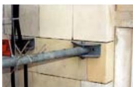
Крепление строительного лифта-подъемника к кладке из керамического пустотелого камня при реконструкции высотного здания «сталинской» застройки
